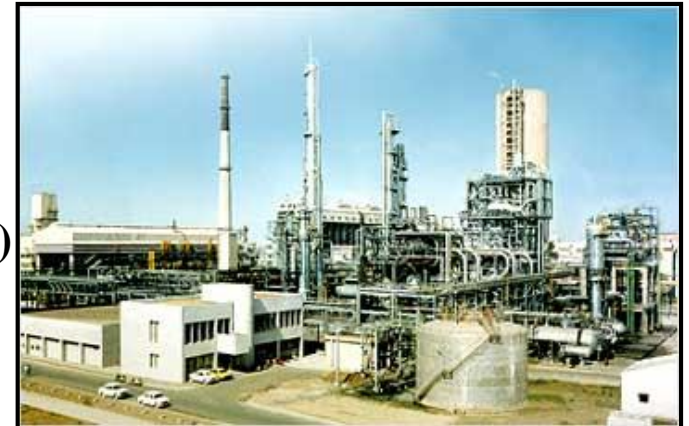
Anlage zur NH 3 -Produktion
