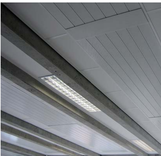
Abb. 8-1: Deckenstrahlplatten
