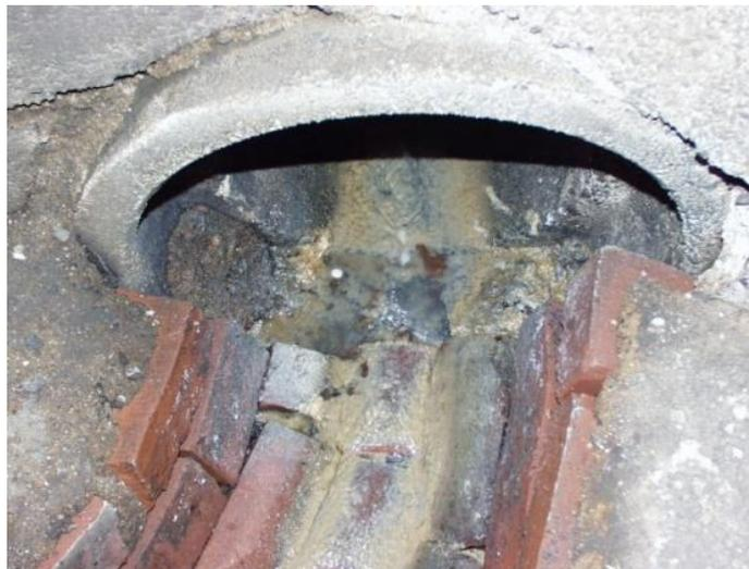
Schacht auf Rohrleitung abgesetzt, Sohle lose Ausmauerung undicht
