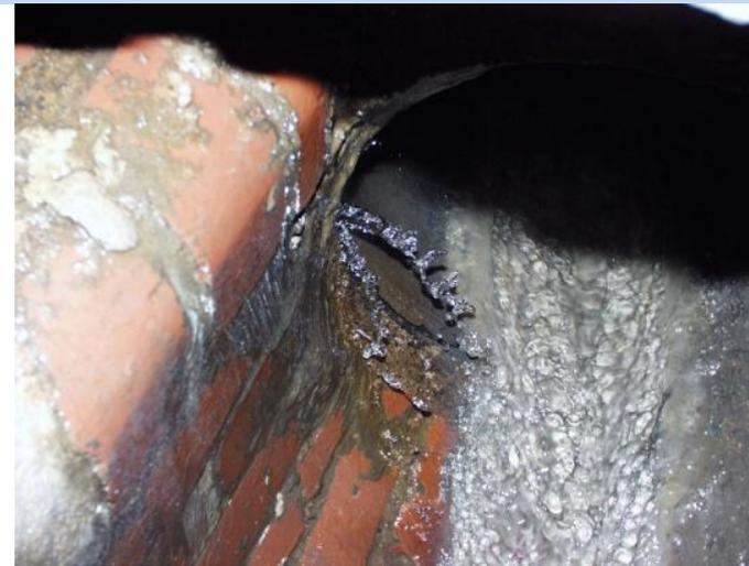
Schachtsohle / Rohrverbindung, Undichtheiten
