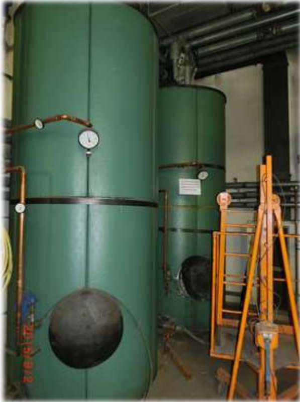
Speicher-Trinkwassererwärmer
