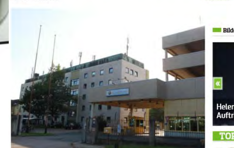
Die Zentrale Polizeidirektion. Die Ergebnisse von Wasserproben lösten gestern bei Mitarbeitern eine Legionellen-Panik aus. Ein Aushang warnt vor den Bakterien © Florian Petrow
