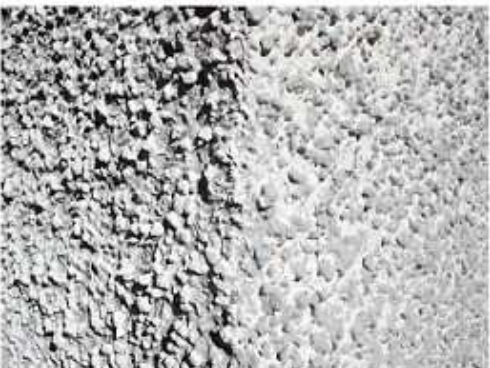
Schulhaus Mattenhof, Zürich, Grundierung des Putzes über Eck © B.E.R.G. Architekten, Zürich
