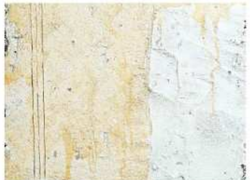
Kalkputz Foto: Manuela Schubert
