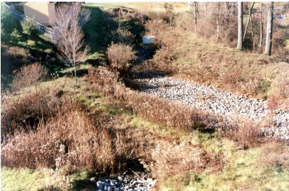
Abb. 1: Umsetzung einer Rigolenversickerung mit einem offenen Kiesbeet (Bildquelle: Moreau1, Public domain, via Wikimedia Commons)
