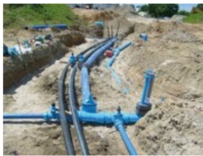
Abb. 1: Verlegung eines Anergienetzes in Biberach (Bildquelle: BauGrund Süd).
