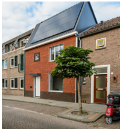
Abb. 1: Saniertes Haus nach dem Energiesprong-Prinzip (Bildquelle: Energiesprong).
