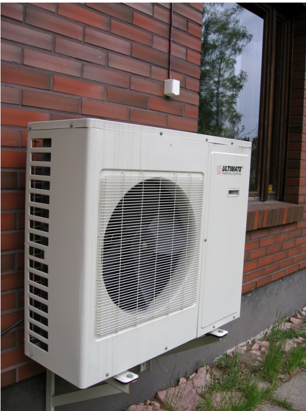
Abb. 1: Links: Außenaufstellung einer Luftwärmepumpe (Bildquelle: Ppntori). Rechts: 14 000-kW-Absorptions-Wärmepumpe zur Nutzung industrieller Abwärme in einem österreichischen Fernheizwerk (Bildquelle: Reinraum).
