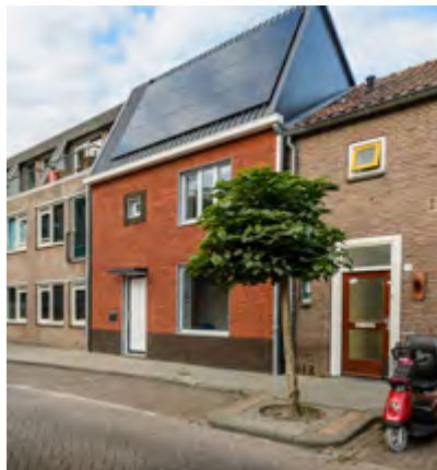
Abb. 1: Saniertes Haus nach dem Energiesprong-Prinzip (Bildquelle: Energiesprong).
