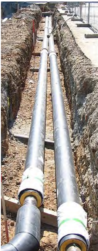
Abb. 1: Links: Fernwärmeleitung aus Kunststoffmantelverbundrohren in der Bauphase (Bildquelle: Björn Appel). Rechts: Oberirdische Leitung über B36 in Mannheim (Bildquelle: Frank-m).
