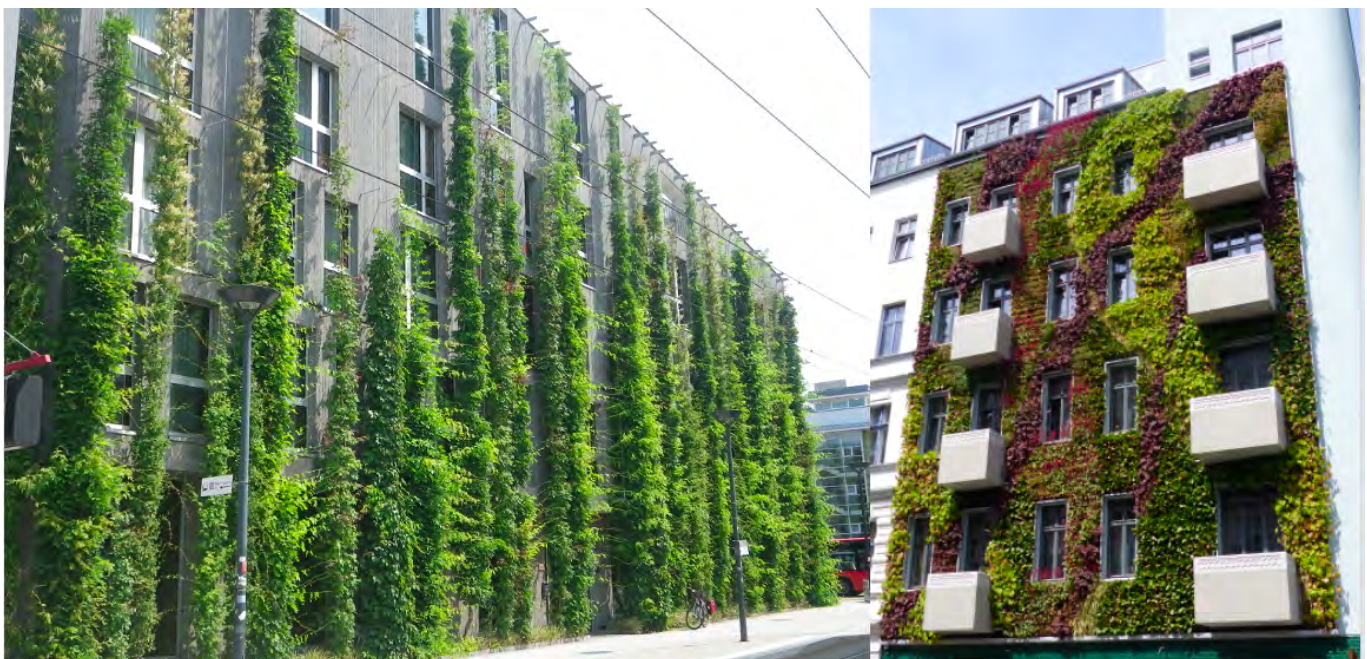
Abb. 1: Erdgebundene (li.) und systemgebundene (re.) Fassadenbegrünung (Bildquelle: Mathias Uhl)
