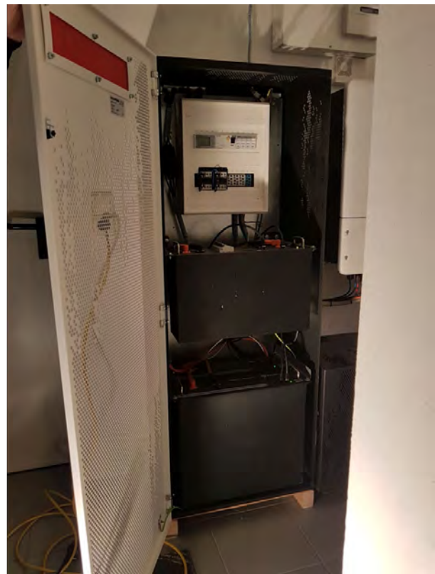
Abb. 1: Eine Batteriebank für eine unterbrechungsfreie Energieversorgung (Bildquelle: Jelson25). Batteriespeicher für eine Heim-Photovoltaikanlage (Bildquelle: Asumipal).
