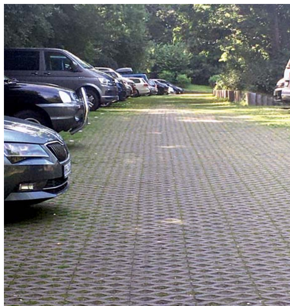
Bild 3: Rasengittersteine auf Parkplatz- fläche. © Söfker-Rieniets et al.
