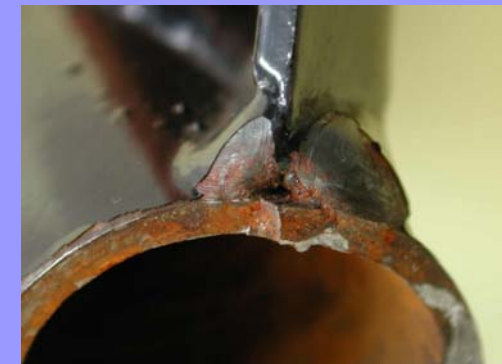
Schwingfestigkeit Schweißverbindung - Korrosion
